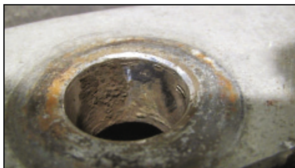
Γαλβανική διάβρωση στην περιοχή του παξιμαδιού.
