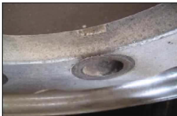
Γαλβανική διάβρωση στην περιοχή του παξιμαδιού και στο εσωτερικό της κεντρικής οπής.
