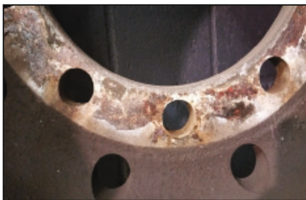
Γαλβανική διάβρωση στις επιφάνειες επαφής της ζάντας.
